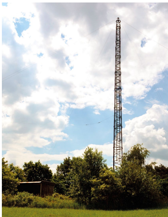
Obr. 2 Vysílací anténa typu dvojitá delta na stanici Průhonice u Prahy.
