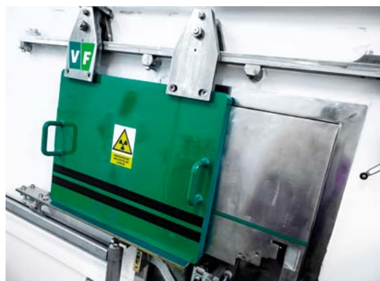
Obr. 1 Stínění vstupu do ozařovací kobky.
