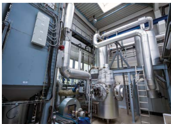
Obr. 1 Technologie LOCA (vlevo – teplovzdušný systém, dole – malá LOCA nádoba, nahoře – přehřívač páry).
