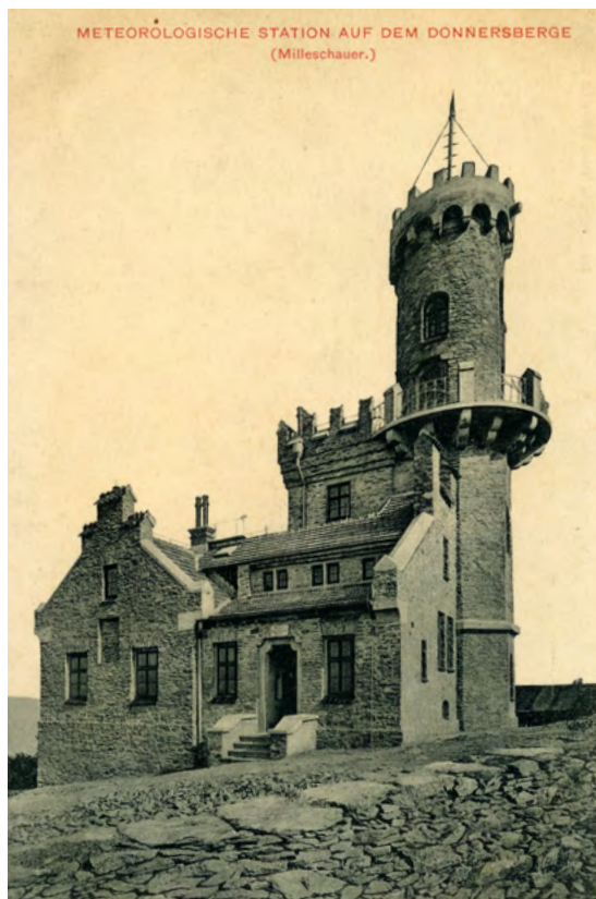
Obr. 1 Observatoř Milešovka krátce po vybudování, ještě bez fasády. Vzhledem k vysokohorským podmínkám ovšem zdi rychle degradovaly a po krátké době musela být observatoř opatřena omítkou.
