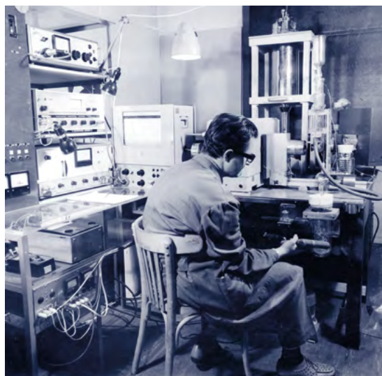
Obr. 1 Fotografie laboratoře luminiscenční spektroskopie na KCHFO asi v první polovině 70. let 20. století. V popředí sedí dr. Fiala s tzv. bzuknou v ruce. Vysoký objekt vpravo vzadu je francouzský kryostat TBT a vedle vpravo menší skleněný kryostat. Za hlavou experimentátora je monochromátor SPM-2 (Carl Zeiss, Jena) a vlevo od něj je zapisovač (s vertikálně posuvným papírem) pro registraci signálu z fotonásobiče. Vlevo jsou shromážděny různé měřicí přístroje, zdroj vysokého napětí atd. Zdroj: sbírky KCHFO
