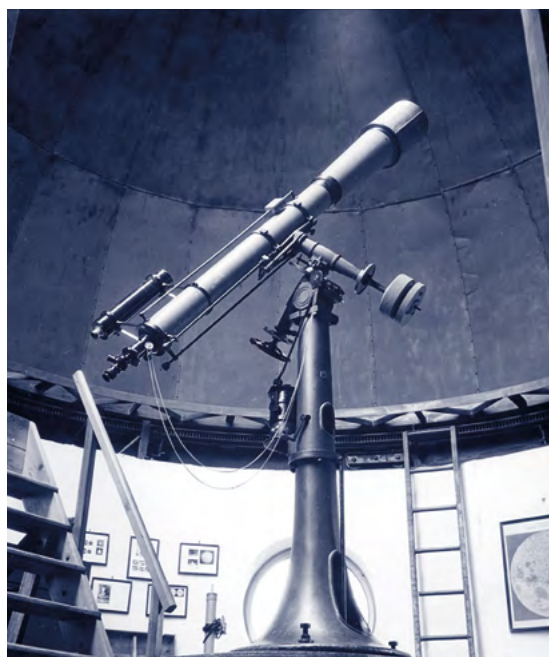
Obr. 1 První dalekohled brněnské hvězdárny, zapůjčený z VUT v 50. letech 20. století. Přístroj měl ohniskovou vzdálenost přibližně 180 cm a objektiv o průměru asi 20 cm. Byl vybaven mechanickým hodinovým strojem s pohonem závažím. Foto: Dr. Karel Raušal
