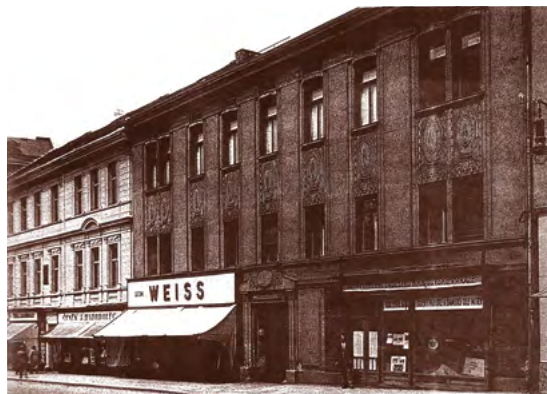
Obr. 1 Historická budova v Žitné 25 byla sídlem Jednoty českých matematiků a fyziků od počátku 30. let. Jednota nechala přistavět rozsáhlou nádvorní část dokončenou roku 1938.
